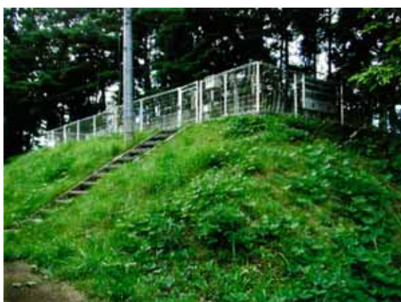
「山小屋配水池」
