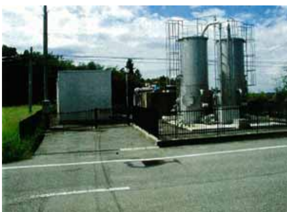
「上代ポンプ場」
