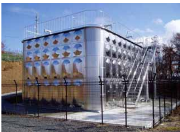
「粟踏石配水池」
