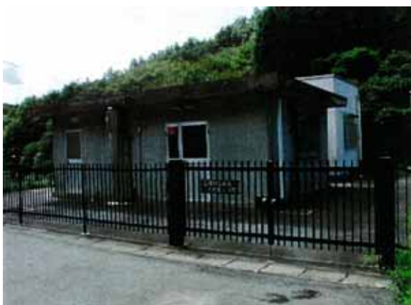
「丈田ポンプ場」
