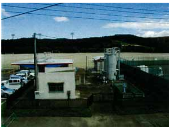
「大谷地ポンプ場」
