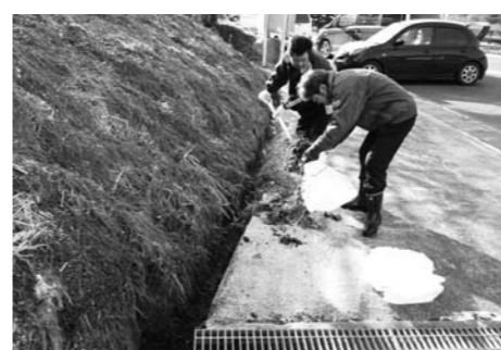
四辻新田地区の除染作業
