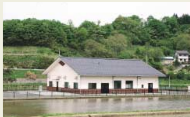
須釜地区農業集落排水処理施設
