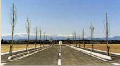
1988年3月 県営玉川工業団地完成
