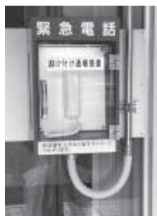
設置された 「駆け付け通報装置」
