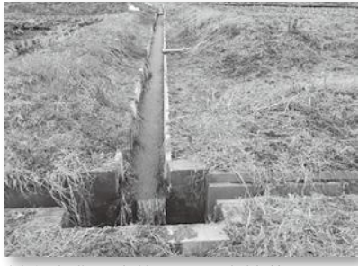
村単事業で実施された竜崎藤岡三ツ池下流U字溝布設
