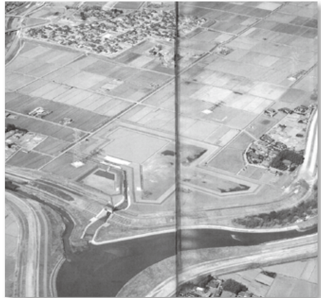
茨城県母子島遊水地 (整備後)
