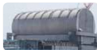
使用済み燃料が全て取り出された3号機原子炉建屋
