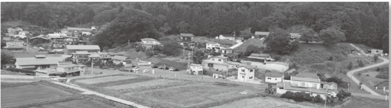
水道施設整備が進む四辻新田地区
