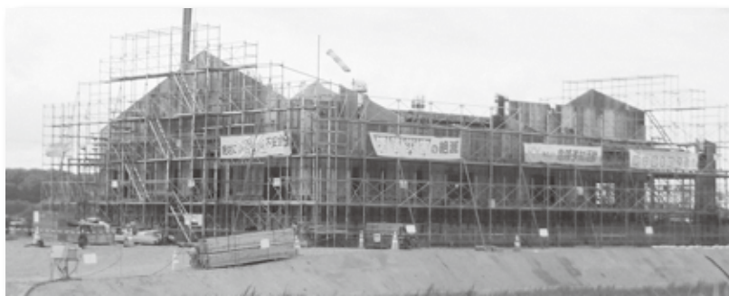
建設中の農業集落排水処理場
