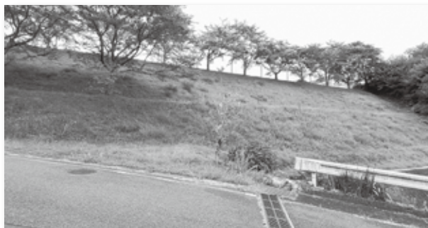
円弧すべり工事場所
