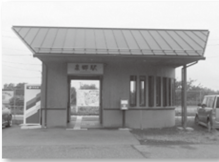
仮設トイレ設置予定の泉郷駅
