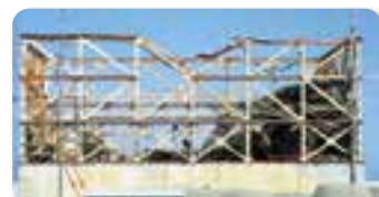
上部カバーが外された1号機原子炉建屋
