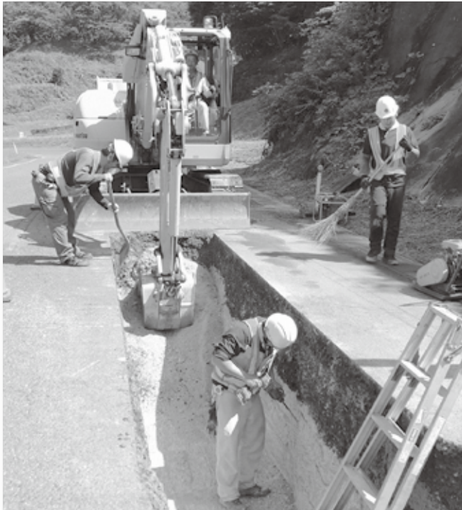
送水管・配水管の工事
