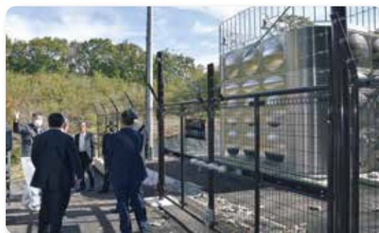
四辻新田地内配水池の現地視察
