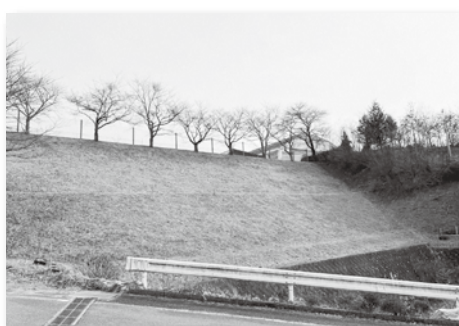
地すべり防止工事箇所
