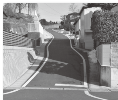
竣工の請願箇所
