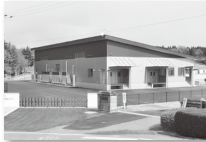
玉川村学校給食センター
