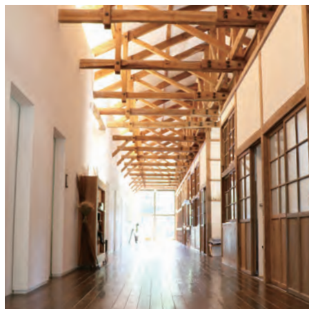
▲宿泊室から常設カフェへ向かうギャラリーは、当時の床材や柱、梁を再利用
