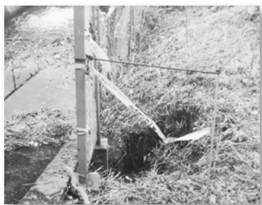
修繕が決まった排水路
