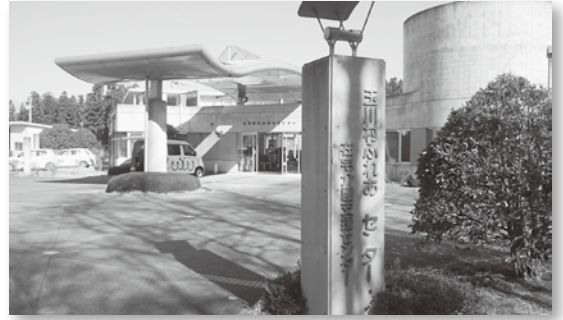
修繕予定の玉川村ふれあいセンター
