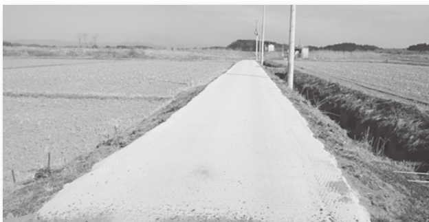
4行政区において満額実施の現道舗装
