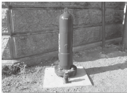
修理された消火栓
