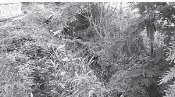
土砂が堆積し、草木に覆われた境沢川（竜崎）
