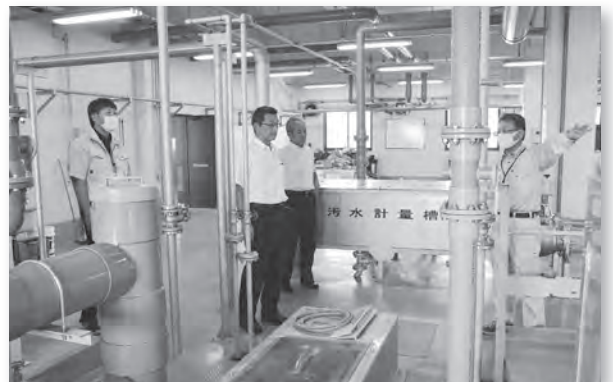
台風19号による被害の復旧工事が行われた竜崎地区処理場
