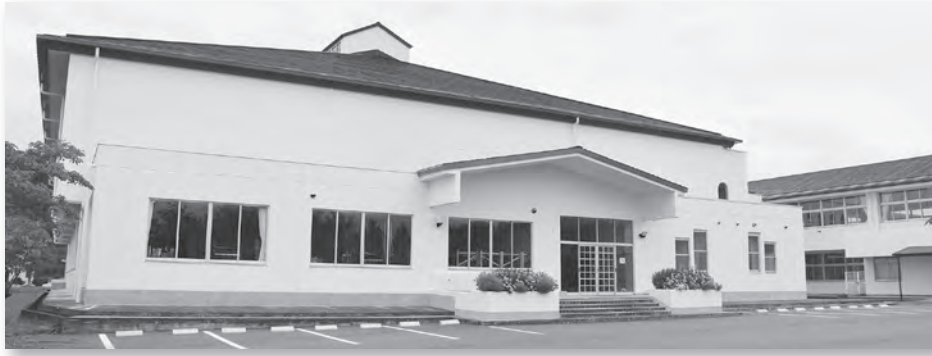
陸屋根（平らな部分）の改修が追加される屋内運動場
