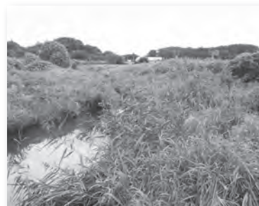
泉郷川・金波川の合流地点 堤防が見えない堆積土砂
