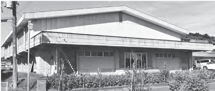
解体される村民体育館
