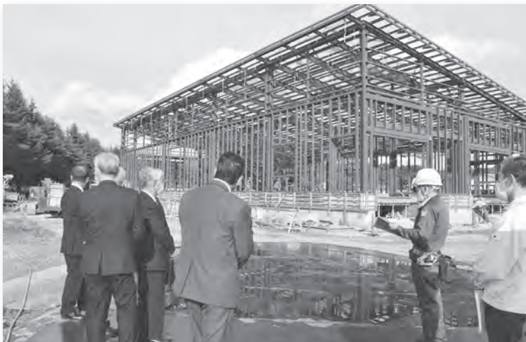
建設中の玉川村学校給食センター
