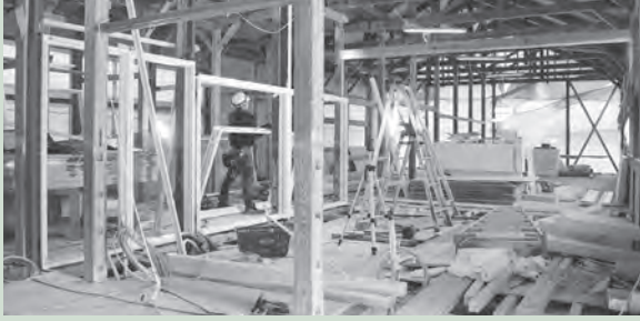
改修工事中の旧四辻分校
