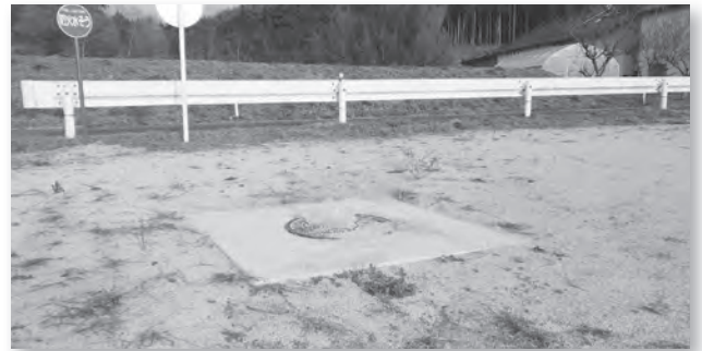
岩法寺区防火水槽
