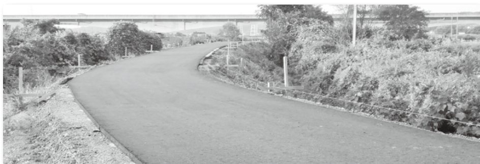
阿武隈川堤防の舗装工事（トラハイ上流）
