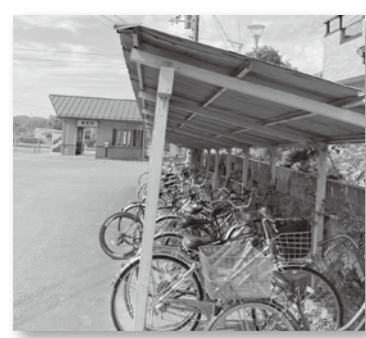
改修予定の泉郷駅駐輪場
