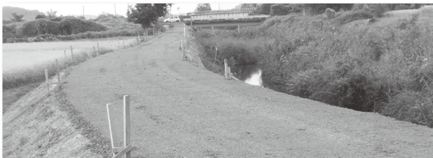
阿武隈川と泉郷川の合流地点の堤防改修、河床浚渫の予定
