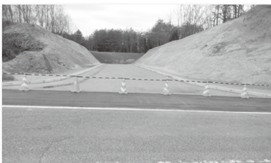
中-16号線 北側から
