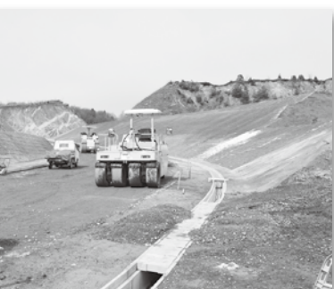
工事中の中-16号線
