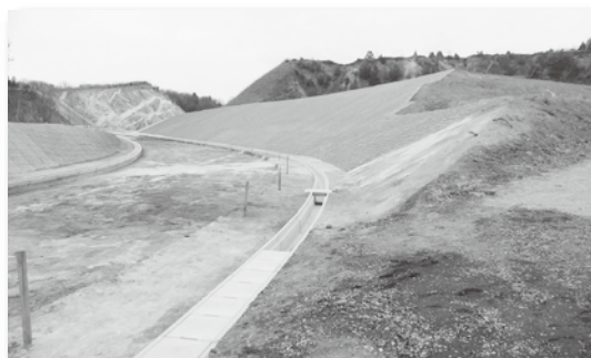
中-16号線 南側から
