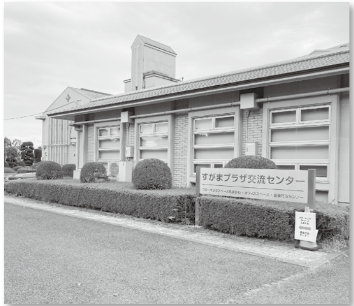
外灯が設置されるすがまプラザ交流センター
