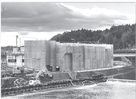
改修が進む「乙な駅たまかわ」
