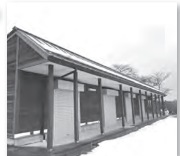
すがまプラザ交流センター 防災倉庫
