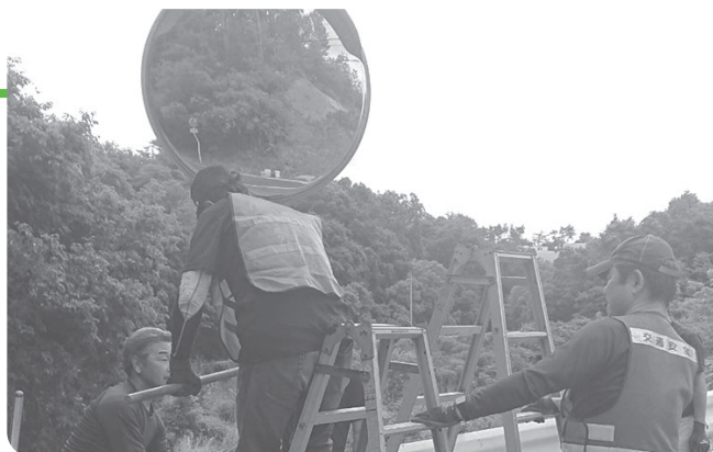
設置作業を行う玉川村交通安全協会の皆さん
