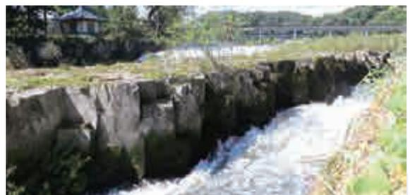
江戸時代に始まった川原田河岸（中島村）から鬼生田河岸（郡山市西田）を結ぶ通船では、乙字ヶ滝が最大の難所となったことから、滝の北側の岩盤を掘削して運河（舟通し）が造られました。（写真手前）着工から3年を経ても完成しなかった難工事で、その跡は現在も見ることができます（写真奥は滝見不動堂）。
