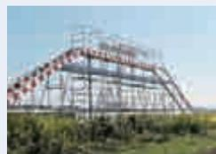
遊水地整備のため付け替えられる村道松ヶ作・神ノ前線の予定断面（竜崎地内）。付け替え後、道路は県道となり、現在の地盤から約6mの高さとなる（歩道を含めた幅員は10.5mを計画）。
