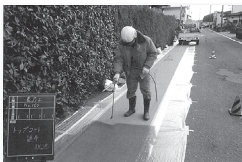
カラー舗装塗布状況
