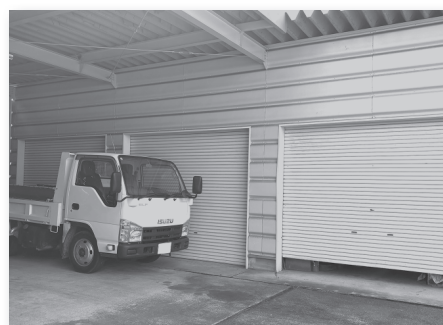
消防・水防倉庫 (左から2番目)
