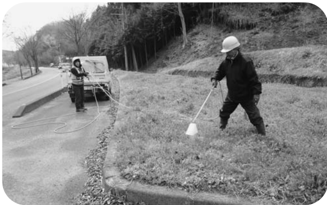
小高地内の村道沿いで散布作業を行う会員
