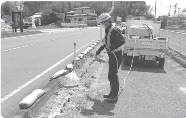
除草剤の散布を行う玉川村建設協力会
