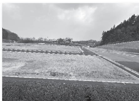
造成工事済みのすがまプラザ分譲地
