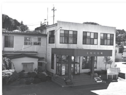
老朽化している役場本庁舎
