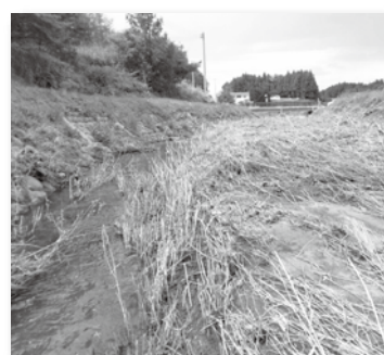
県が発注した泉郷川工事現場（小高字三升蒔地内）
