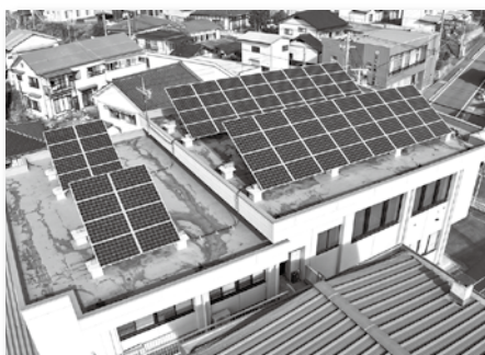
北庁舎に設置された太陽光発電パネル
