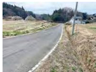
道幅が狭く、高低差のある側溝
