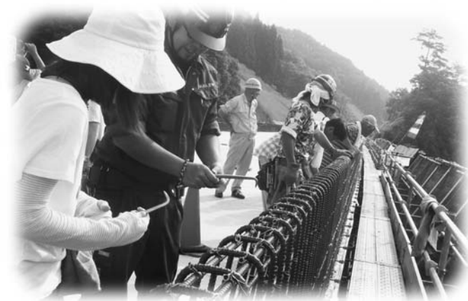
あぶくま高原道路の工事現場を見学する参加者
