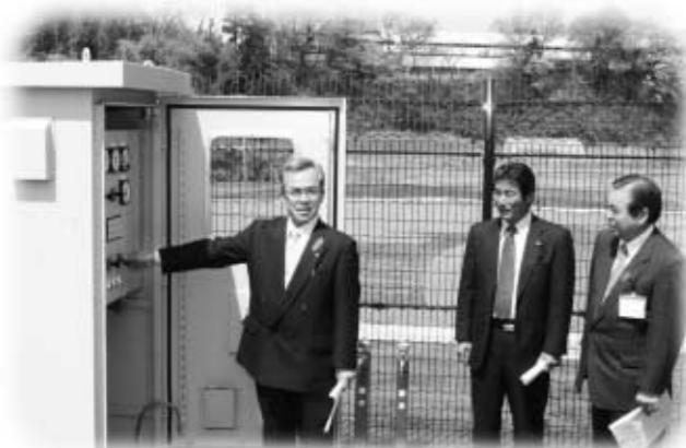
制御盤の運転スイッチを入れる石森村長
