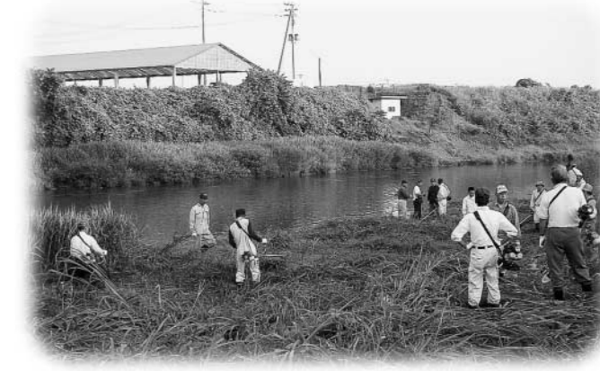
川辺地内の阿武隈川河川敷での作業のようす
