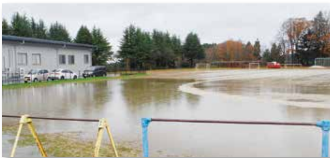
暗渠工事が必要な須釜小校庭
