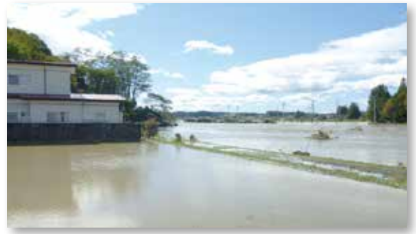
令和元年台風19号での阿武隈川堤防越水
