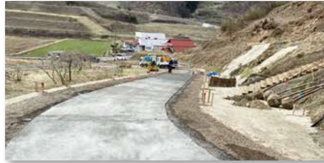
工事中のヨッジ進入路
