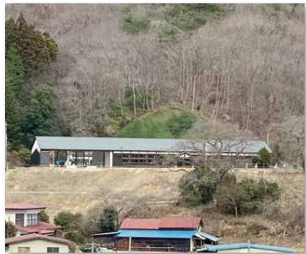
完成間近の森の駅ヨッジ
