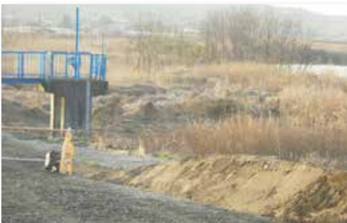
未整備の竜崎地内堤防
