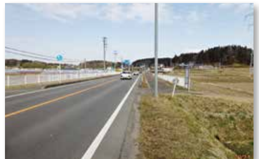
国道118号線の歩道末整備箇所
