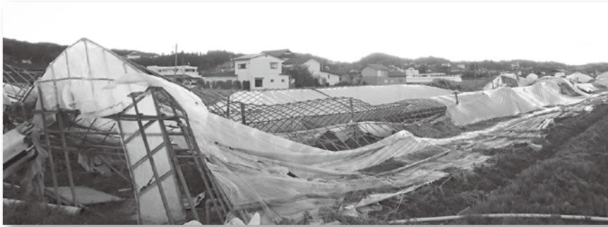
倒壊したハウス(中)
