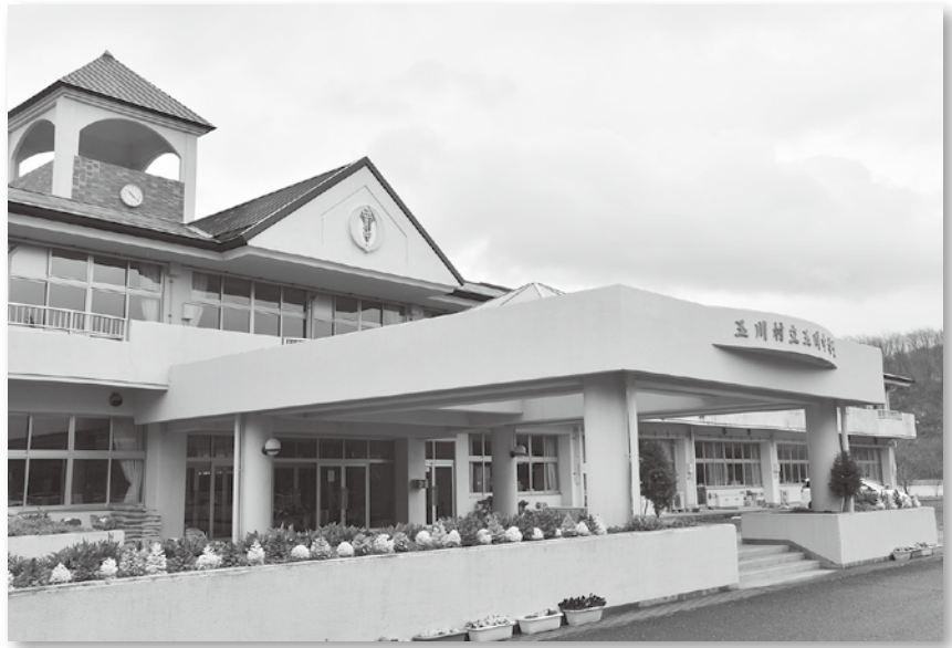
改修工事予定の玉川中学校
