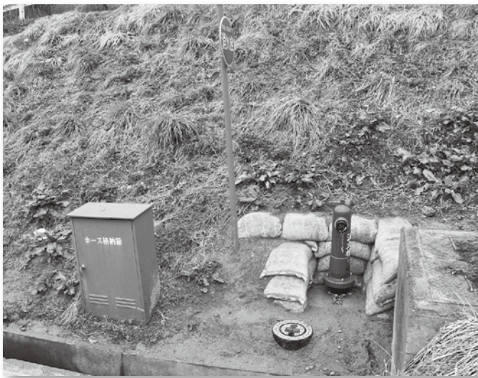
修繕された消火栓(南須釜字蟹沢地内)
