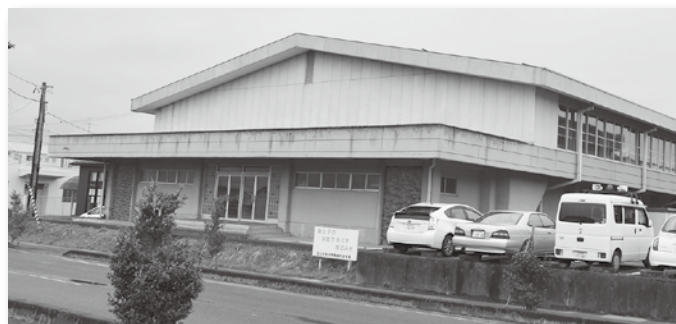
解体される村民体育館
