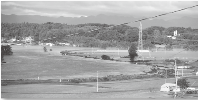
越水している阿武隈川堤防（中地区）
