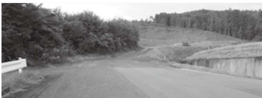
泉中学校裏の道路拡張（起点）
