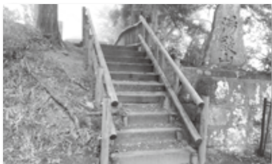
修繕された階段
