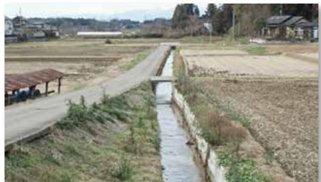
幅が広い水路
