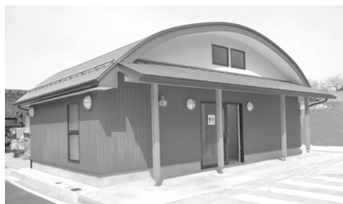
トイレも新しく整備されました
