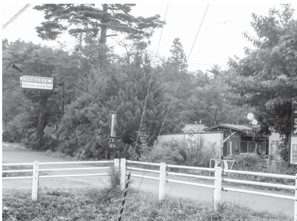
廃屋の対策が必要である
