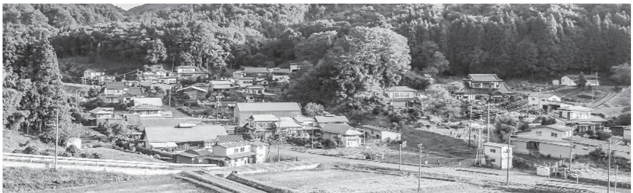
給水が予定されている四辻新田村中地内
