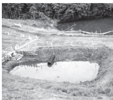
開発地内にある沈砂池
