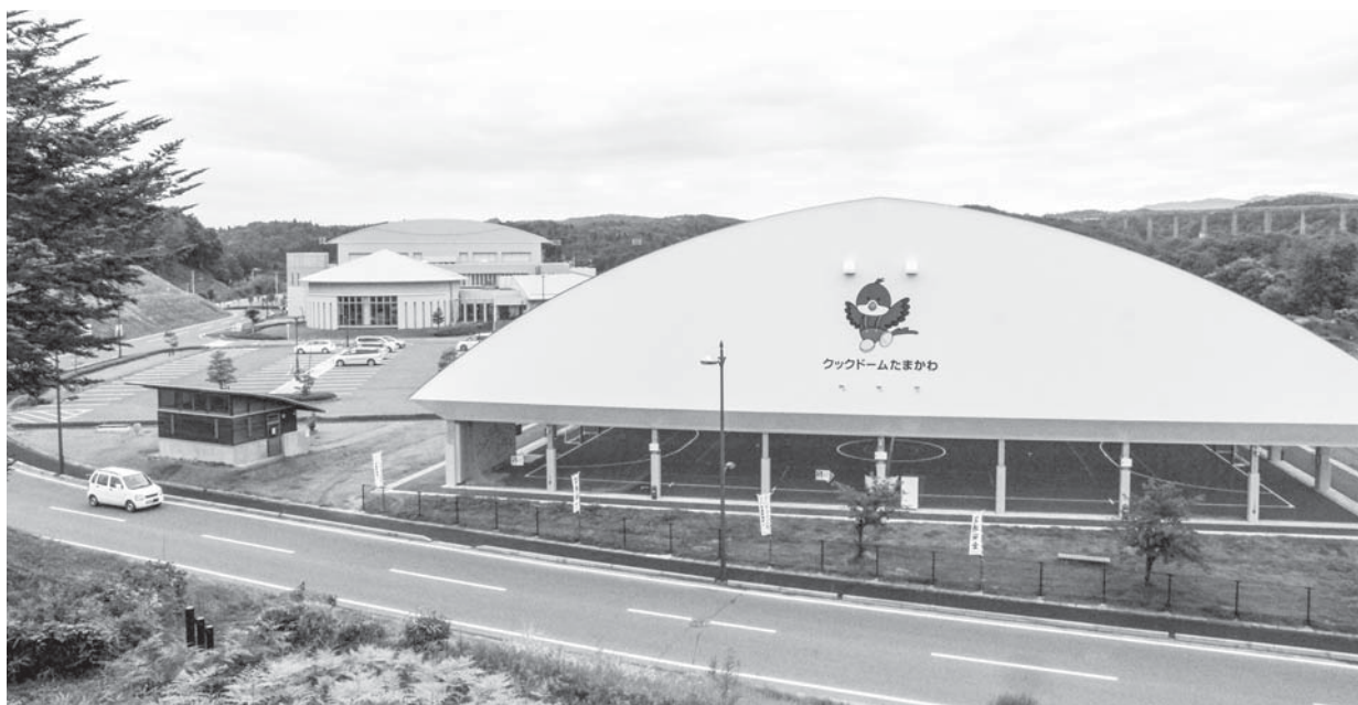
屋根付き広場「クックドームたまかわ」と、たまかわ文化体育館
