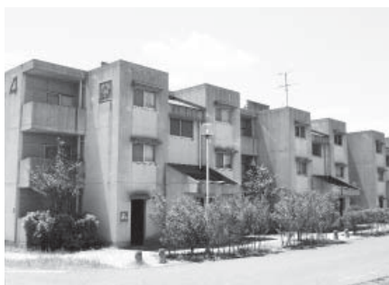
中層耐火構造の村営住宅
