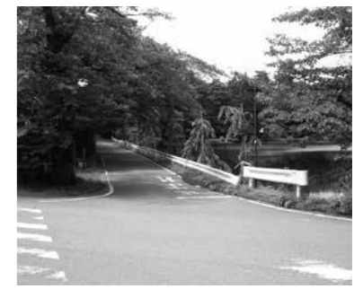
村道中一16号線の終点付近
