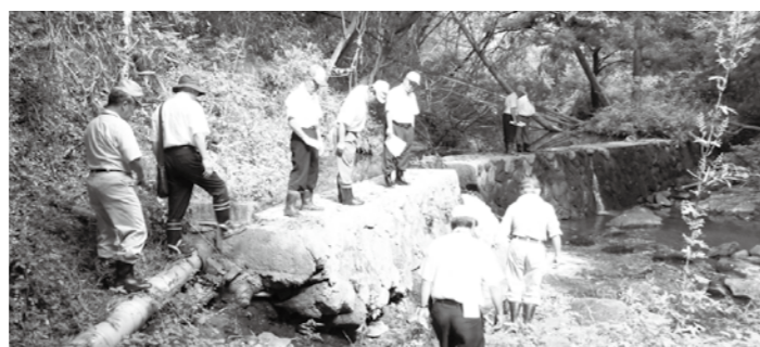
採択された沢向地区の頭首工
