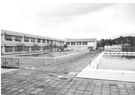
使用中止となった学校プール(須釜小)
