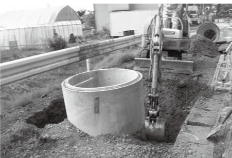
災害復旧工事のようす
