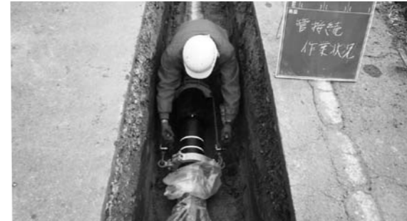
上水道の水道管敷設工事(5年計画で耐震性も向上)
