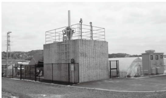
阿武隈川の水位上昇を防ぐ漏水防除機
