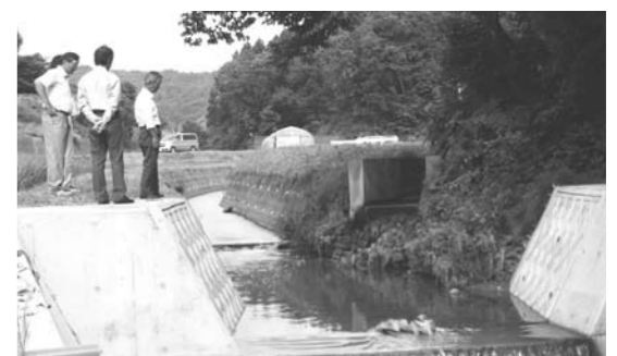
豪雨災害による河川復旧工事箇所(北須釜)の説明を受ける監査委員
