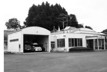
須賀川消防署玉川派出所
