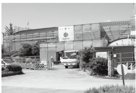
玉川第一小学校体育館耐震補強工事
