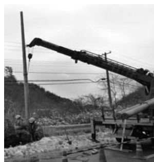
建柱作業の様子
