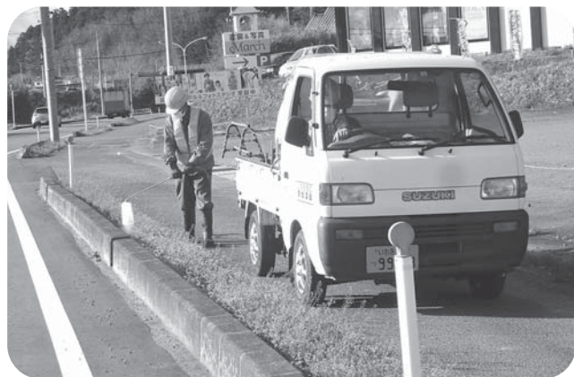
除草剤の散布を行う建設業協力会
