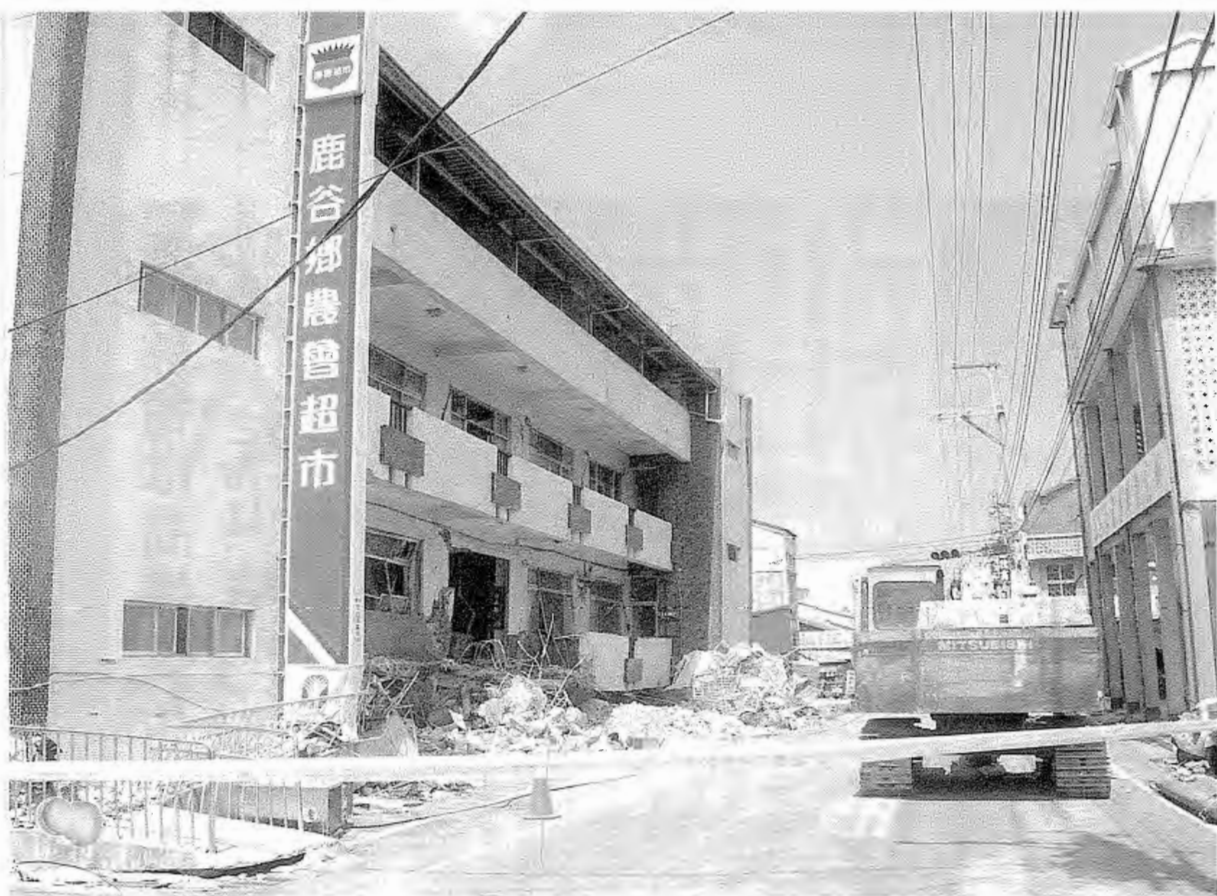
1階部分が押し潰されてしまった鹿谷郷農會の建物（左側）
