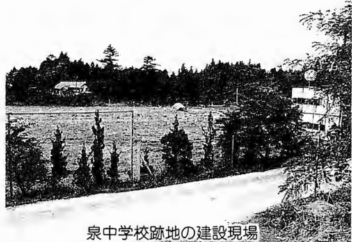
泉中学校跡地の建設現場
