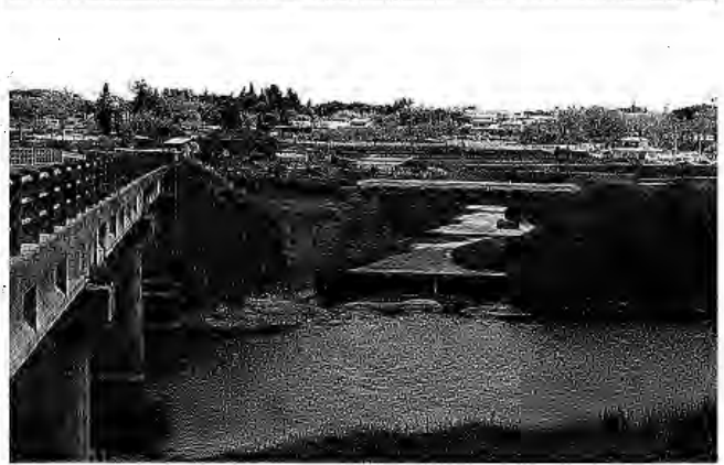
1 ここが泉郷川の終点。手前が阿武隈川で左が県道千五沢・矢吹線の玉城橋です。水が少ないなあ。 2 泉郷川と金波川の合流地点。河川の護岸工事でとてもきれいになっていた。でも、草がずい分とのびていたよ。
